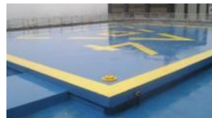
Sinalizadores da TLOF
