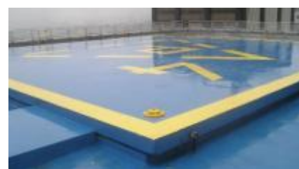
Sinalizadores da TLOF
